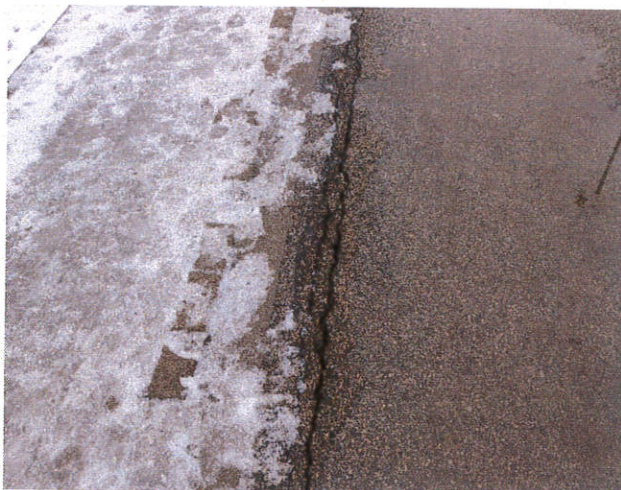
Nevienmērīgas sēšanās rezultātā parādījušās plaisas.
