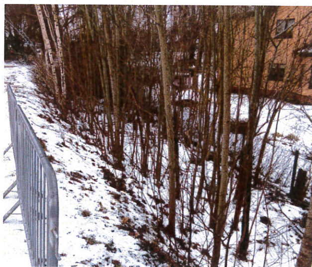
Iekšējā nogāze ar slīpumu 1:2, un ēkas pietiekamā attālumā.
