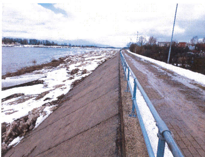
Labā krasta stiprinājums stāv bez izmaiņām. Ūdens pilsētas apbūves teritorijā ienācis pa plaisaino dolomīta slāni.
