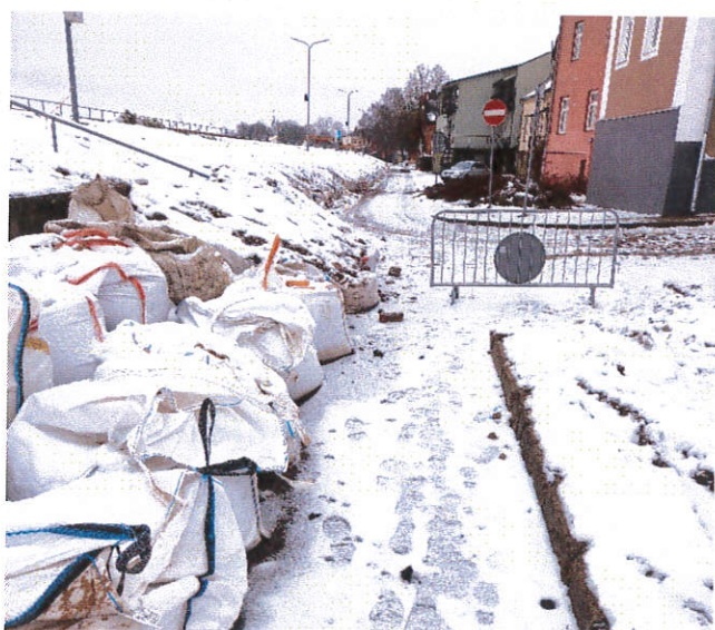
Ar smilšu maišiem nostiprināts posms.
