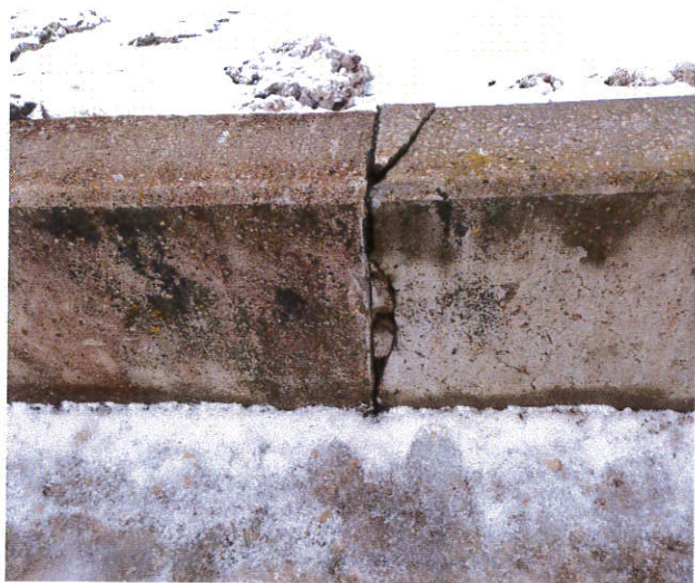
Sēšanās rezultātā deformēta šuve.
