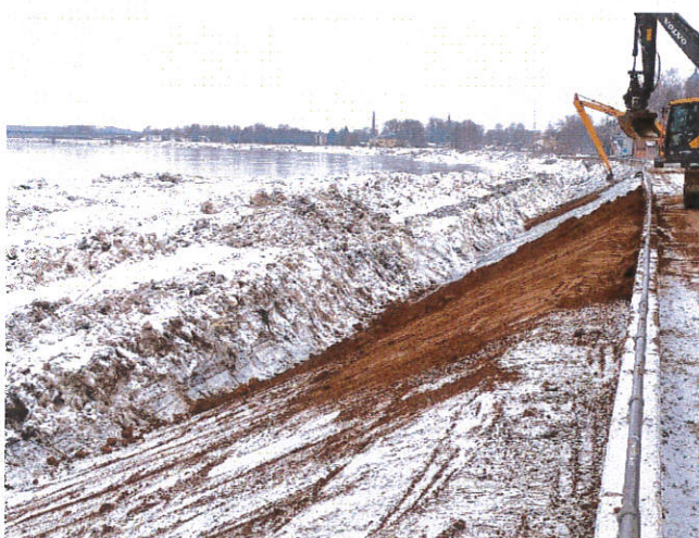
Nogāze stiprināta ar bentonītmāla paklāju un piebērumu.
