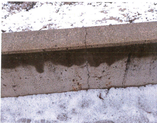
Nevienmērīgas sēšanās rezultātā parādījušās plaisas.
