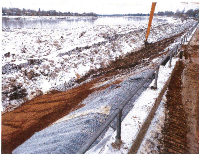
Slapjās nogāzes stiprinājums ar bentonītmāla paklāju.
