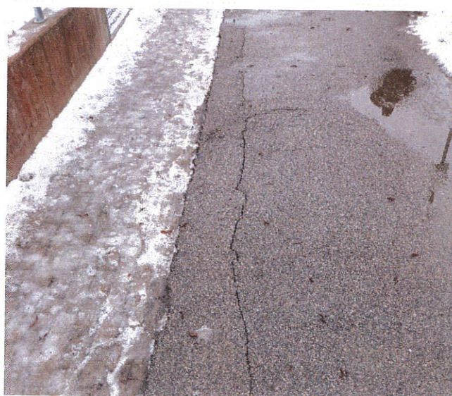
Nevienmērīgas sēšanās rezultātā parādījušās plaisas.
